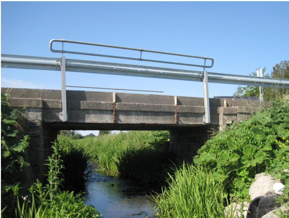
Foto 10: Hele bygværket: Facade mod øst
