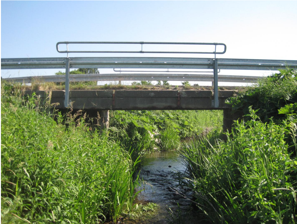
Foto 1: Hele bygværket: Facade mod vest
