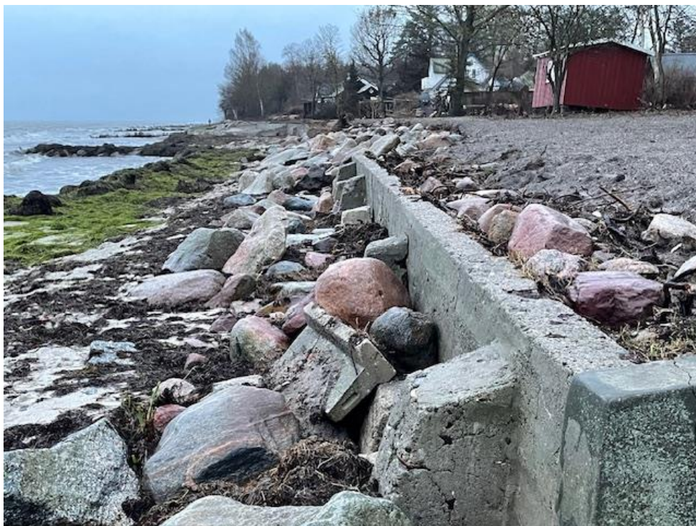
Figur 2-11 Matrikel nr. 3 muren og stenkastning set mod syd efter stormfloden
