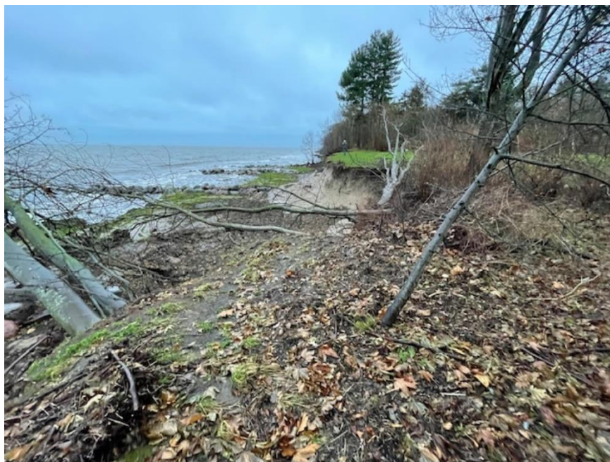
Figur 2-28 Hul i kystskrænten mod nord i nr. 13
