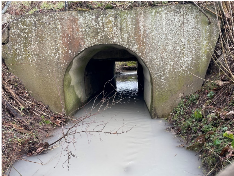
Figur 1: Udløb stenkiste er en firkantet konstruktion i granit. Indløb i stenkiste er en rund konstruktion i beton
